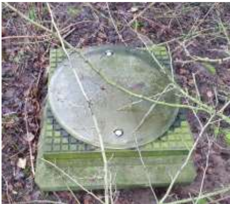
Figuur 2: 'Deksel' boven faunabuis 1 Reitscheweg. Lekkage?
