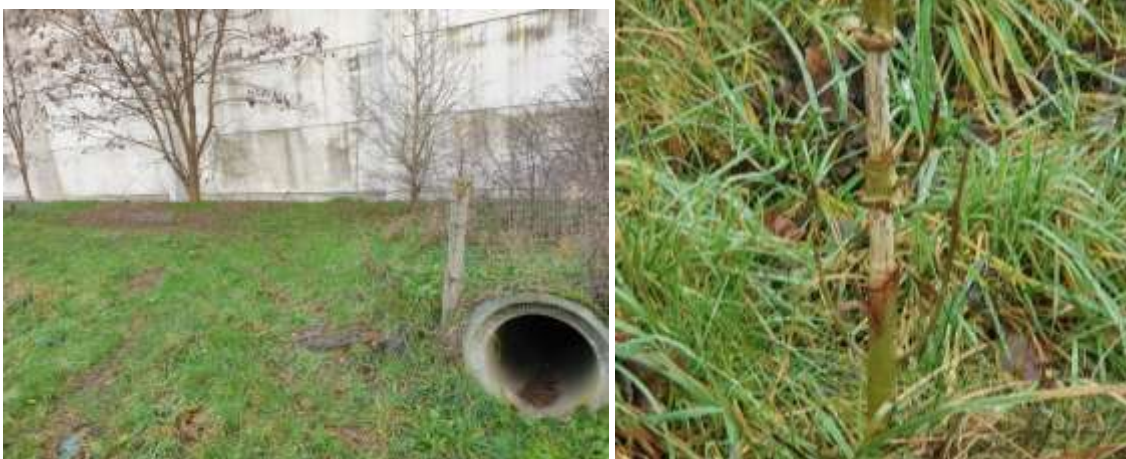
Figuur 5. Faunabuis westzijde A2. Links: ingang buis, gevoelig voor inregenen. Rechts: veegsporen ree.
