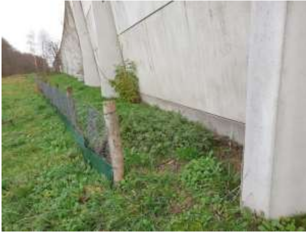
Figuur 4. A2 - geluidsscherm - hek - faunabuis . Links: slechte aansluiting aan geluidsscherm, zodat dieren langs geluidsscherm blijven lopen en niet bij faunabuis komen. Rechtsboven: bovenaanzicht huidige situatie met faunabuis (A), slechte aansluiting (B) en gat in hek (C). Rechtsonder: voorgestelde situatie met hek dat dwars aansluit aan geluidsscherm en dieren dwingt om langs de faunabuis te lopen.
